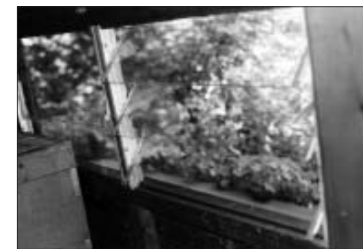
Sehr gut geeignetes Fenster für Bienenstände mit vier schräg zu stellenden Scheiben zum Abflug der Bienen aus dem Innenraum.
