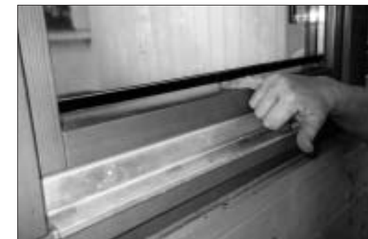
Die Detailansicht des Fensters zeigt den ständig geöffneten Fluchtspace für die Honigbienen zwischen Scheibe und Fensterrahmen.
