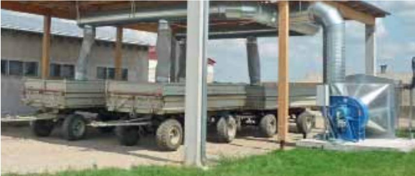
**PFFIFFIGE LÖSUNG** Vom Gebläse (rechts) wird die im Wärmetauscher mit dem Kühlwasser des BHKW erwärmte Luft durch die Rohrleitungen zu den Anhängern gedrückt.
