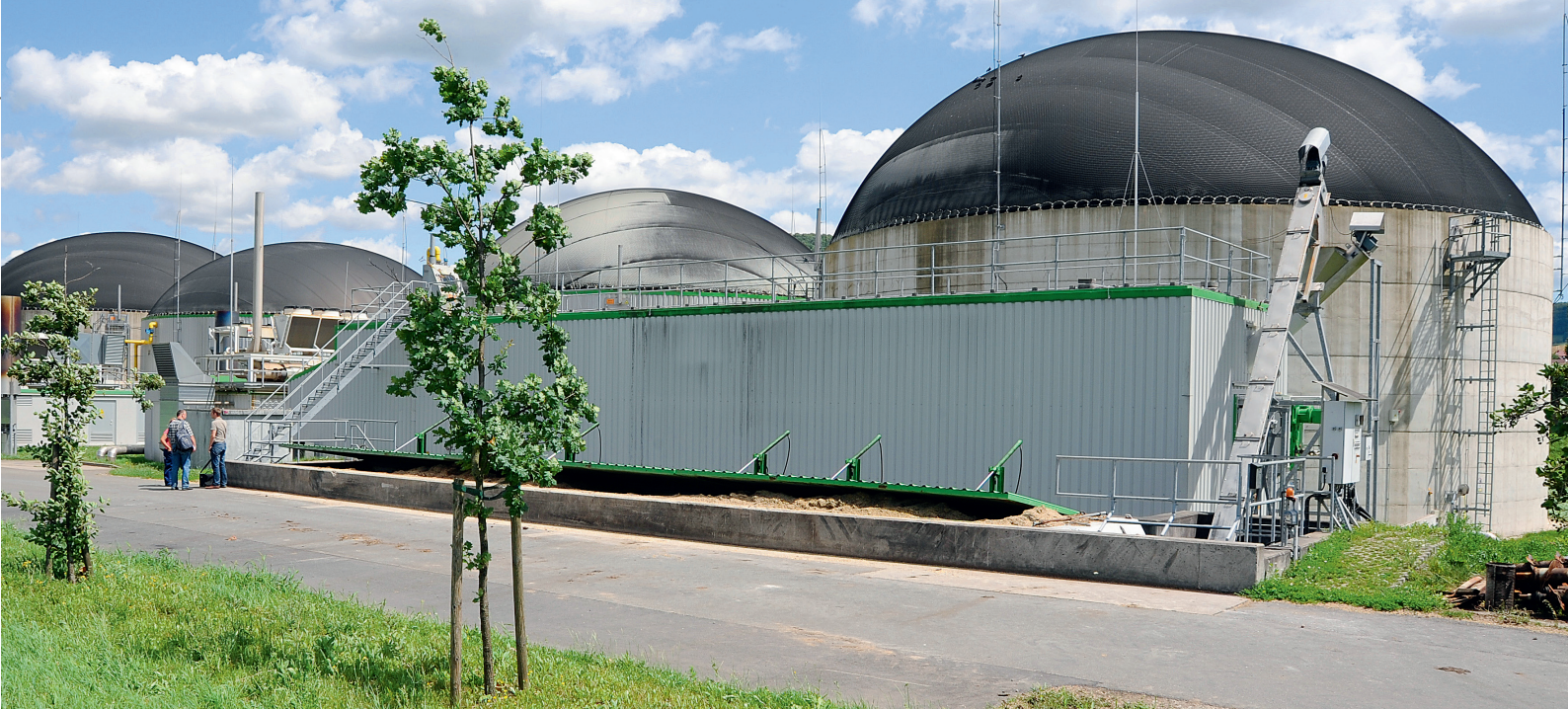
Die beiden Biogasanlagen auf dem Gelände des Klärwerkes in Jena. Im Vordergrund die Anlage „Alma“, die zuerst mit einer Ultraschall-desintegration nachgerüstet wurde.
