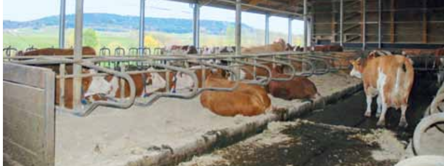
Blick in den dreireihigen Offenfrontstall. Die Liegeboxen sind dick mit einem Stroh-Kalkgemisch eingestreut. Dies wird mit einer Einstreumaschine alle 14 Tage erledigt. Die Laufgänge sind planbefestigt, über dem Laufgang am Futtertisch befindet sich eine Berieselungsanlage.
