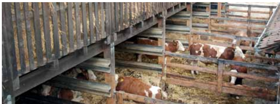
Ein ehemaliges Rübenlager wurde in einen Tretnistall für die Zuchtbullen umgebaut. Über den planbefestigten Auslauf gelangen die Bullen in den Stall mit Spaltenboden, dort wird auch gefüttert.
