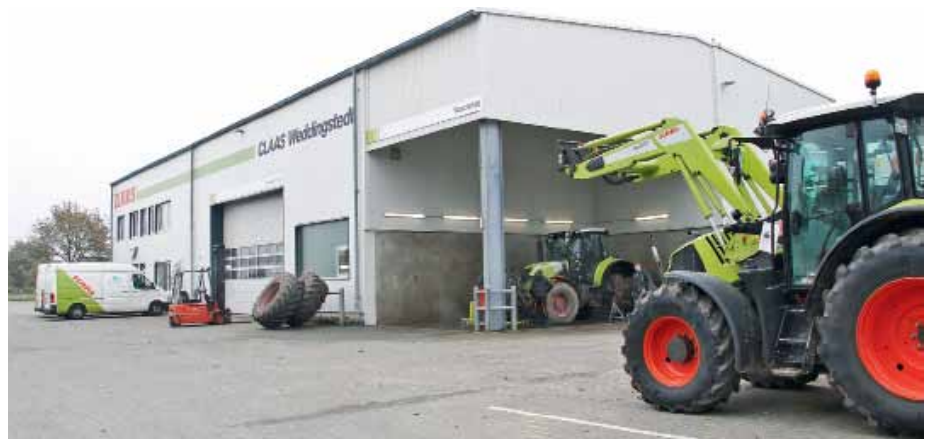
Der Waschplatz ist offen, aber dennoch überdacht. Auch auf Details wird geachtet, zum Beispiel der Bügel, an dem Reifen angelegt werden können, ohne die Wand zu verschmutzen.
