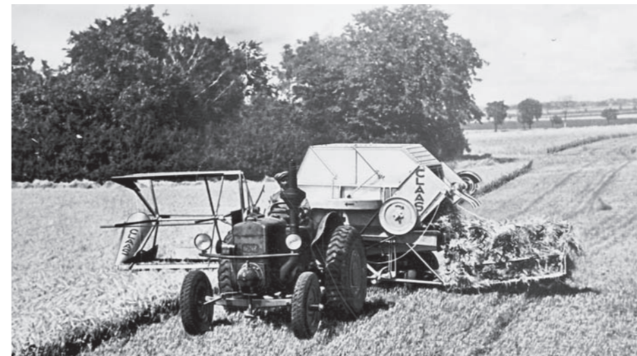
1936 bestand der Claas MDB erfolgreich den Praxistest und wurde zum ersten Mähdrescher Europas. Fotos: DLM/Uni Hohenheim
