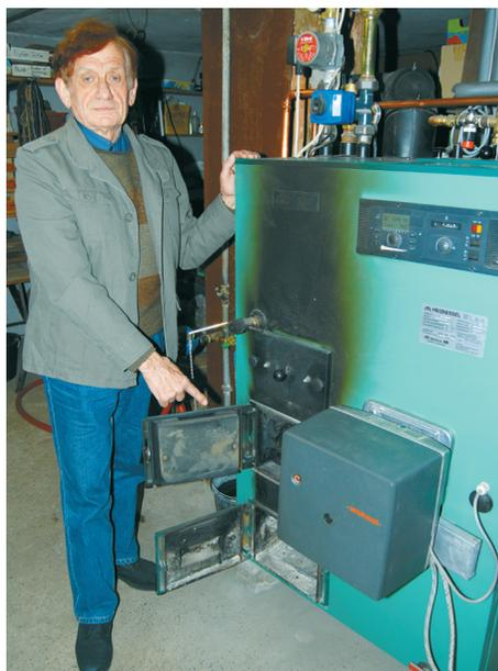
In der vor vier Jahren installierten Wechselbrand-Heizungsanlage, für die Klaus Kolster fast 10.000 € investierte, kann sowohl Öl als auch Holz verbrannt werden.
